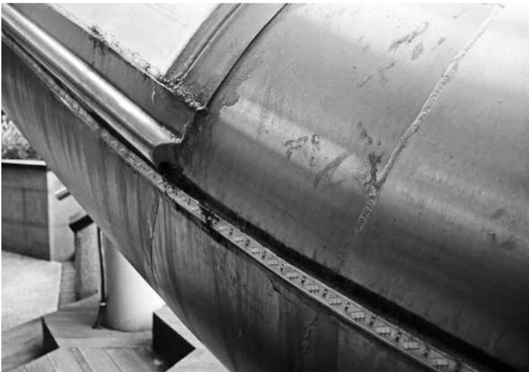
圖 6 「喂！溜滑梯」(Weeeee! Slide) 上色澤深淺不一的紋路、凹痕、焊瘤、接縫汙漬與 LED 燈條。
